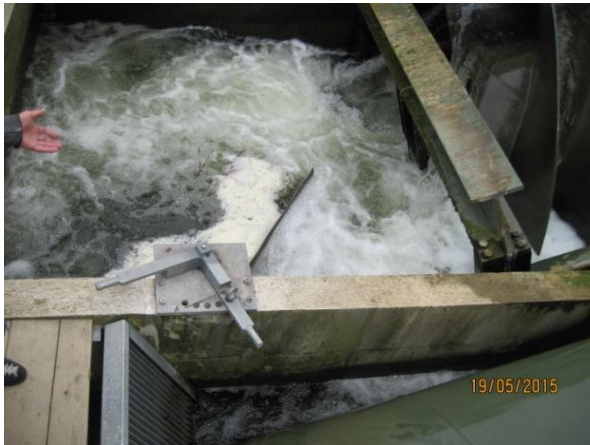
Joonised 2 ja 3. Kompensatsioonivee värav kalatõstuki taga (vasakul) ja paisu alumises bjeffis sissepääs kalatõstukisse (paremal).
