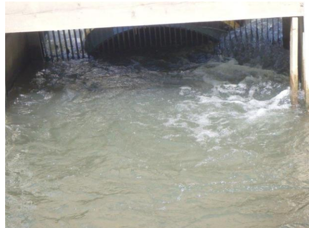
Joonised 2 ja 3. Kompensatsioonivee värav kalatõstuki taga (vasakul) ja paisu alumises bjeffis sissepääs kalatõstukisse (paremal).
